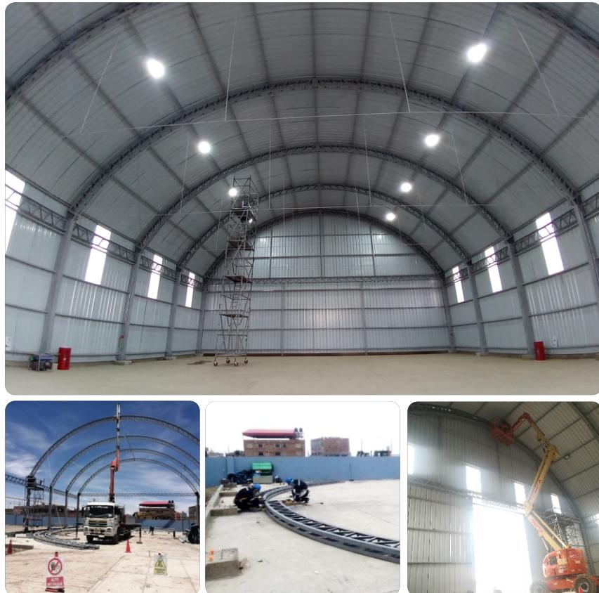
✓ Construcción de galpones 2500m2 con cerramientos laterales y posterior, mejoramiento e instalación de contenedores oficinas. Instalación de iluminación en talleres, suministro e instalación de líneas eléctricas para nave, suministro e instalación de puerta corrediza de acceso, 2.70 x 10 metros de luz, suministro e instalación de líneas de aire. Todas las obras civiles, lozas, dados de concreto, piques de mantenimiento y otros.
