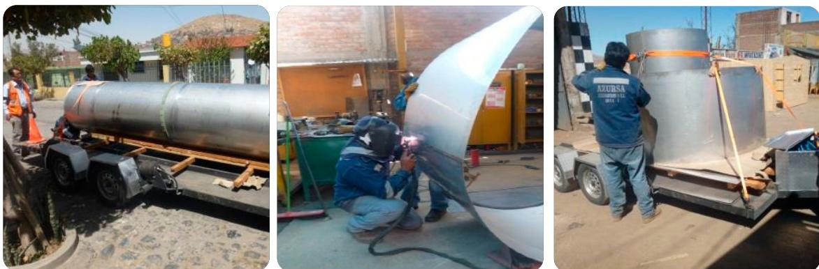
☑ Diseño, fabricación y montaje de cámaras de secado para AJO.
